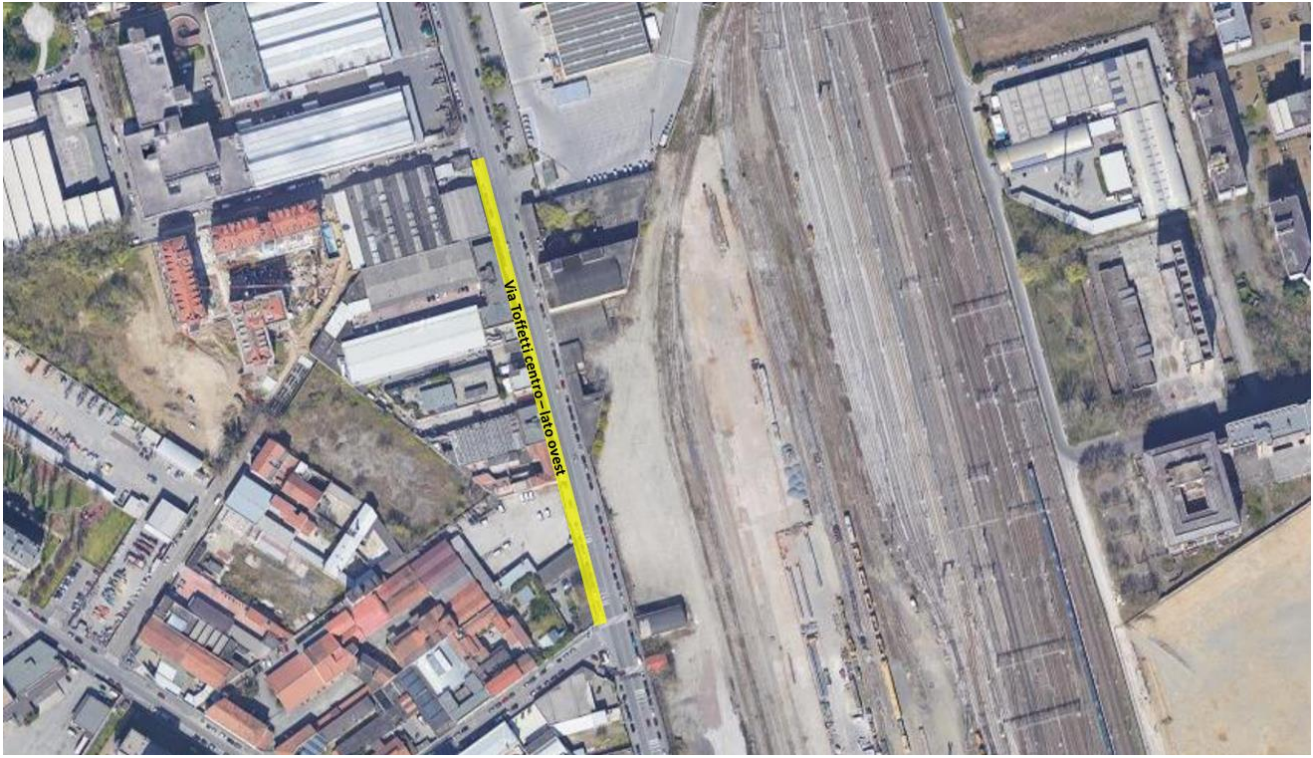
Figura 6 – Sosta via Toffetti, tratta centrale lato ovest della carreggiata
