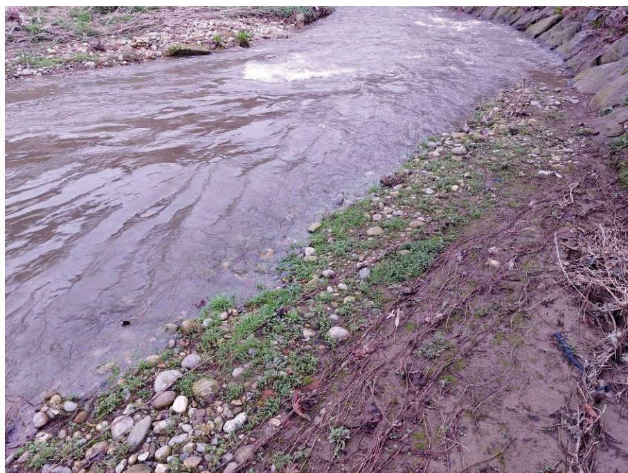
Figura 5.2 – Transetto 2 (alveo e sponda destra)
